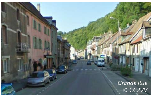
Vue sur Grande Rue et le bâtiment 1911 © ADU
